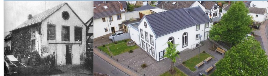
Ehemalige Synagoge in Niederzissen (Dauerausstellung)
